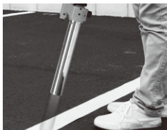
路面のライン施工に
