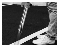
路面のライン施工に
